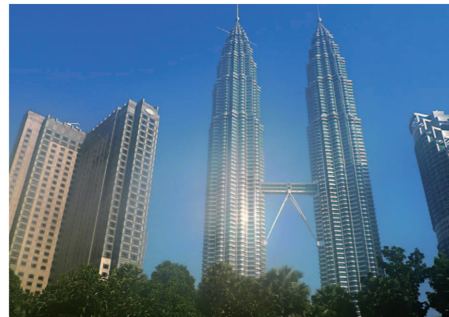
広大なKLシティーパークから望む「Mandarin Oriental, Kuala Lumpur」と、隣接するクアラルンプールを代表するランドマークである「Petronas Twin Towers」の全景
