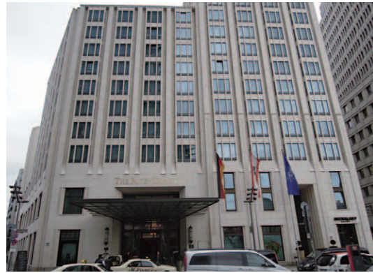
「The Ritz-Carlton, Berlin」の正面ファサード。右隣に高級レジデンス「The Ritz-Carlton Apartment」を併設している
