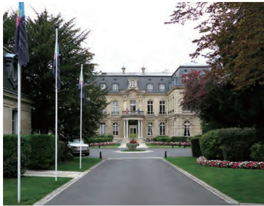
正門から続くアプローチの向こうにレ クレイエールの華麗な正面ファサードが見えてくる
